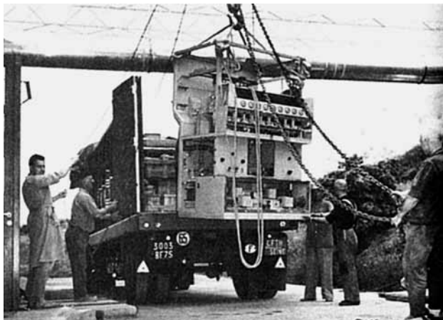
Dobová fotografie z instalace jednoho z přístrojů vysílače... něco jako zesilovač.
